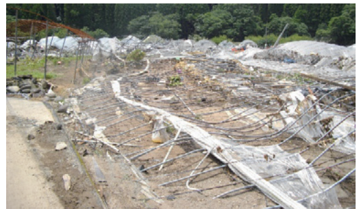
豪雨による土砂の流入で倒壊したハウス
